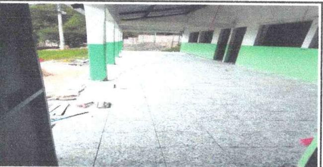
Foto 5: Sustitución de piso de cemento por piso de granito
