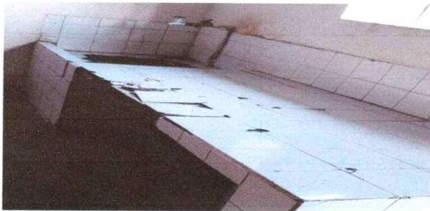
Foto 3: Sustitución de azulejo, llaves, tubería de drenaje y del agua todo está en mal estado.
