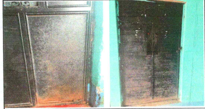
Foto 4: Sustitución de puerta
