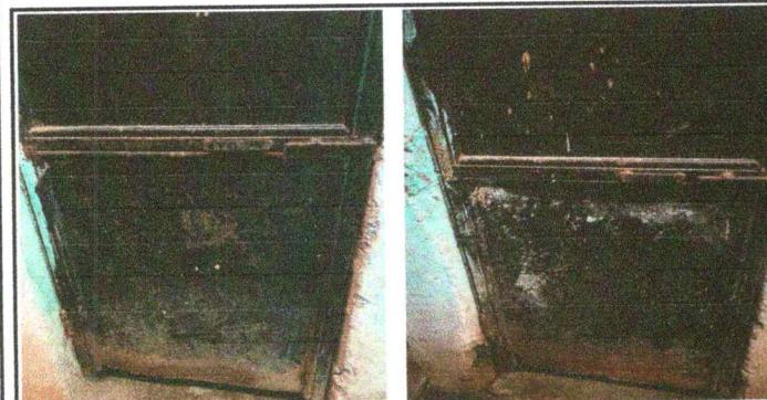
Foto 5: Sustitución de puerta en servicios sanitarios
