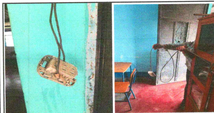
Foto 5: Sustitución de tomacorrientes
