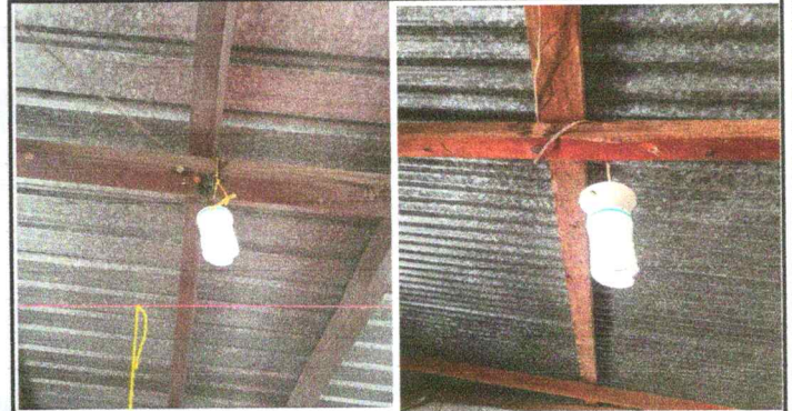
Foto 2: Sustitución de focos ahorradores
