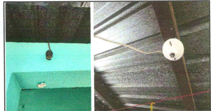
Foto 4: Sustitución de plafoneras
