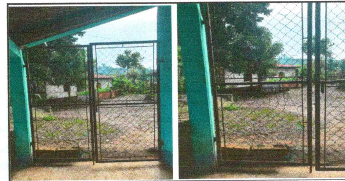
Foto 6: Sustitución de portón de metal
