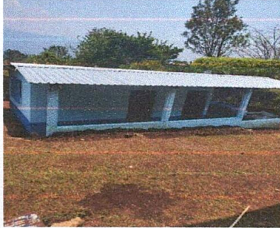
Foto1: Sustitución de lamina
