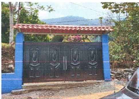
Foto 5: Sustitución de portón de metal e instalación de techo
