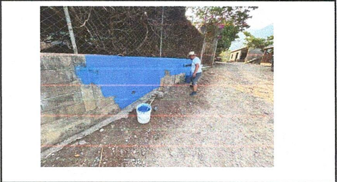
Foto 2: Pintura en muros exteriores e interiores
