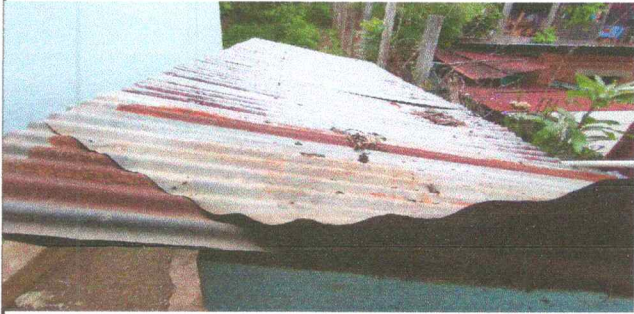
FOTO 1: Sustitución de lámina y estructura de soporte de madera por metal
