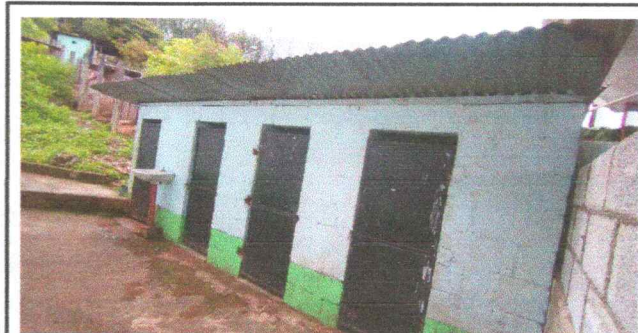
FOTO 3: Sustitución de puertas en servicios de baños
