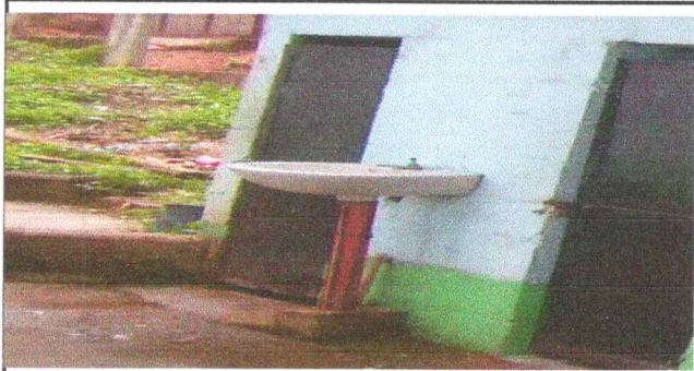
FOTO 7: Sustitución de lavamanos por lavamanos de concreto
