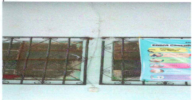
FOTO 16: Sustitución de tomacorrientes
