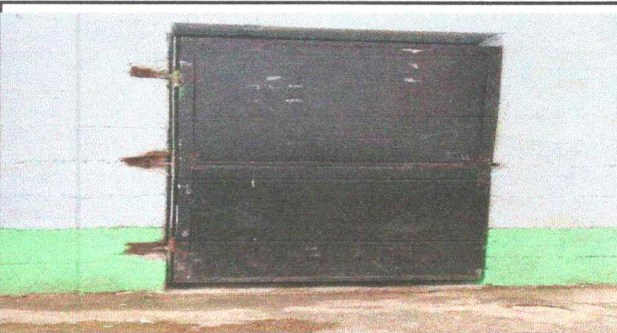
FOTO 3: Sustitución de puertas en servicios de baños
