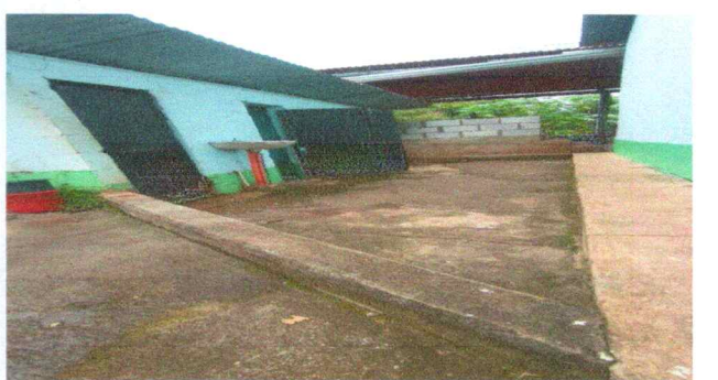
FOTO 11: Reparación de piso de torta
