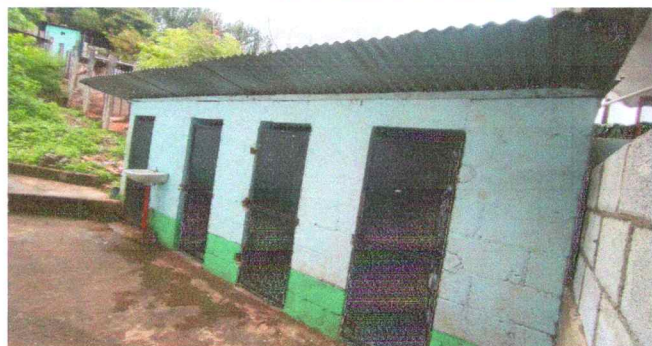
FOTO 10: Repello de pared de baños y muro perimetral
