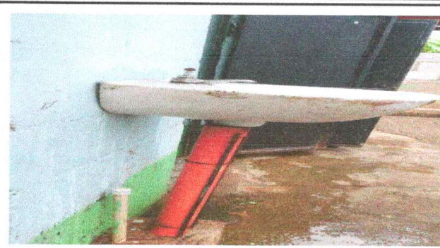
FOTO 7: Sustitución de lavamanos por lavamanos de concreto
