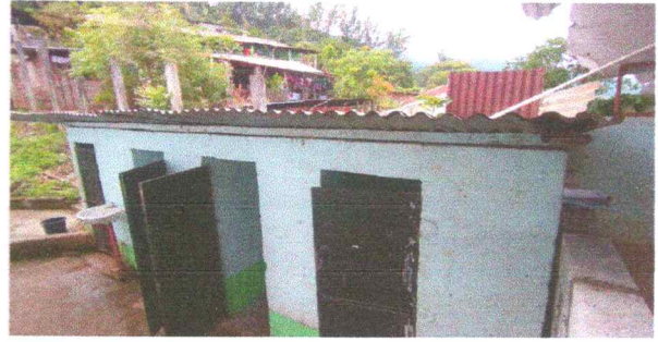
FOTO 1: Sustitución de lámina y estructura de soporte de madera por metal
