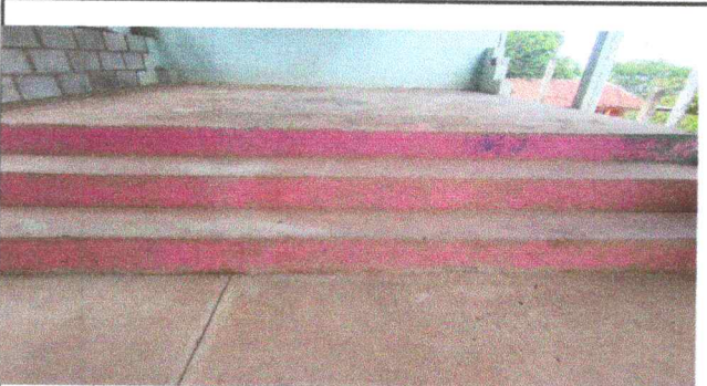
FOTO 5: Sustitución de piso de concreto por piso de granito
