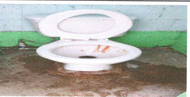
FOTO 6: Sustitución de inodoros
