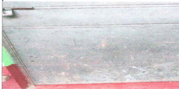
FOTO 2: Sustitución de puertas
