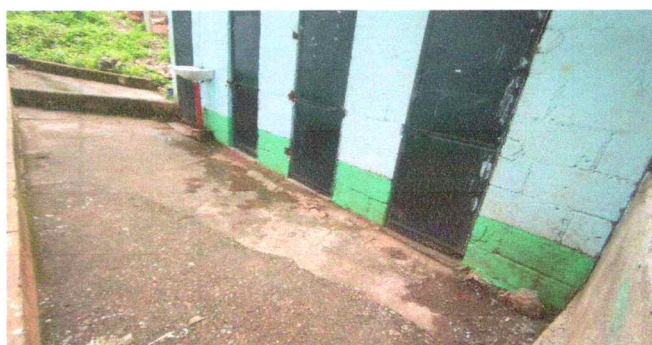
FOTO 11: Reparación de piso de torta
