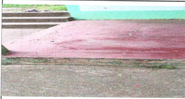
FOTO 4: Reparación de piso de torta
