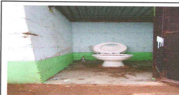
FOTO 6: Sustitución de inodoros
