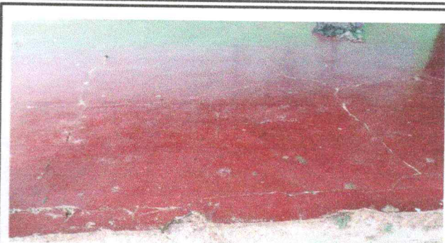
FOTO 4: reparación de piso de torta
