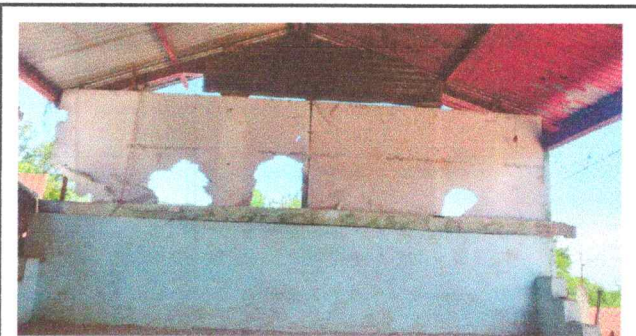
FOTO 9: Mejoramiento de muro de block en ambiente interno (salón)
