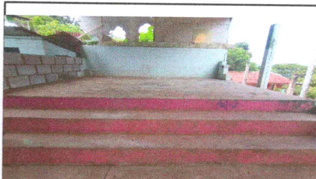
FOTO 5: Sustitución de piso de concreto por piso de granito
