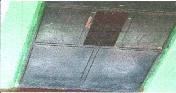
FOTO 2: Sustitución de puertas
