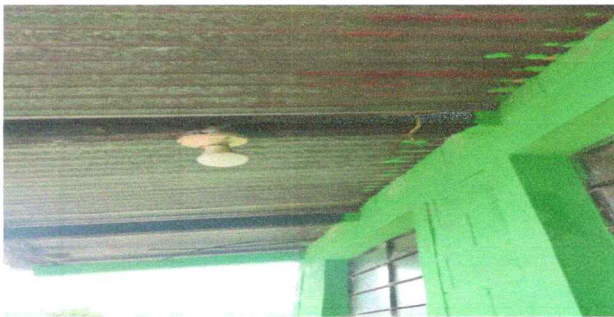
FOTO 17: Sustitución de plafoneras
