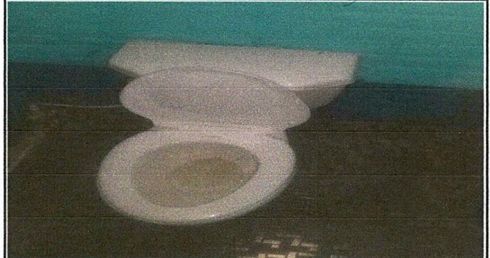
Foto 2: Sustitución de 4 inodoros
