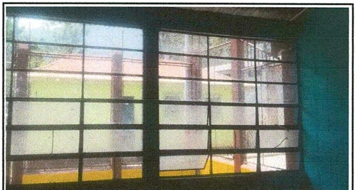
Foto 4: Sustitución de vidrios
