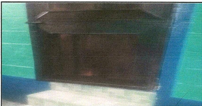
Foto 5: Sustitución de puertas de servicios sanitarios
