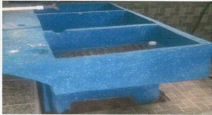
Foto 1: Sustitución de 2 pilas de dos lavaderos
