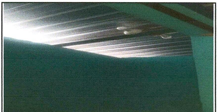
Foto 6: Sustitución de techo servicios sanitarios
