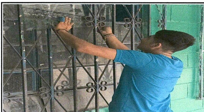
Foto 4: Sustitución de vidrios
