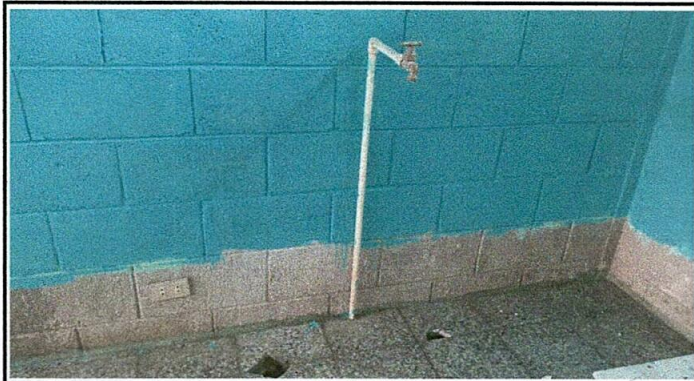
Foto 1: Sustitución de 2 pilas de dos lavaderos
