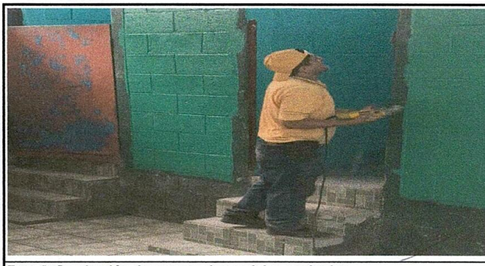
Foto 5: Sustitución de puertas de servicios sanitarios
