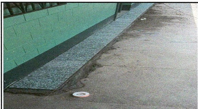
Foto 3: Sustitución de piso
