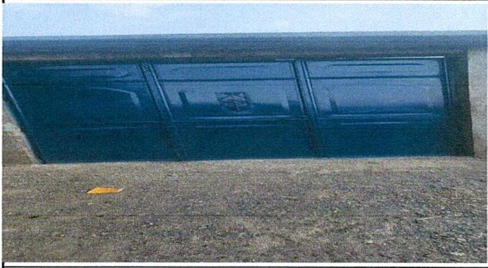
Foto 3: Sustitución de portón de metal
