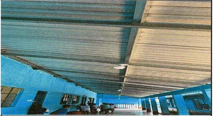
Foto 4: Cambio de sistema electrico
