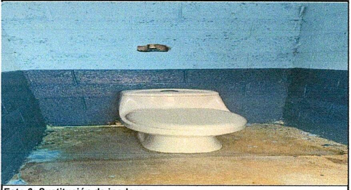
Foto 6: Sustitución de inodoros
