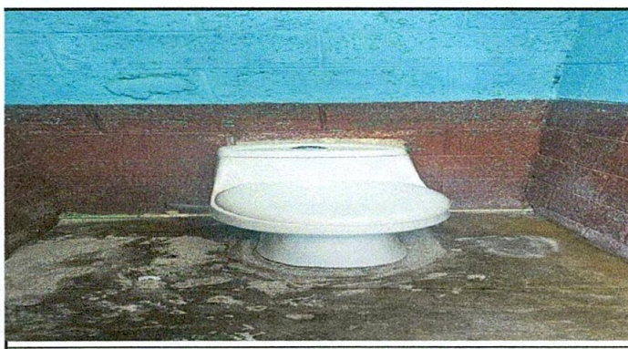
Foto 6: Sustitución de inodoros
