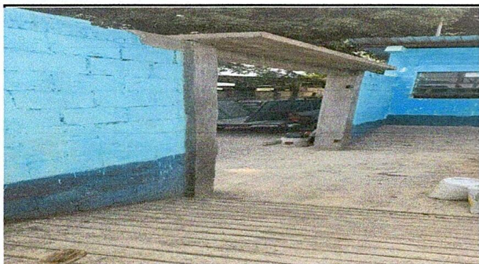
Foto 3: Sustitución de portón de metal
