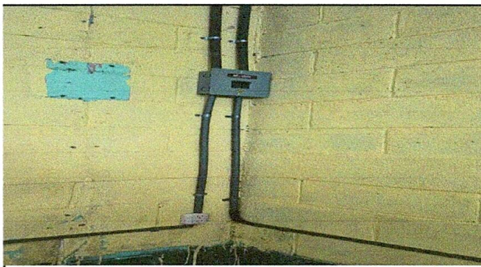
Foto 4: Cambio de sistema electrico
