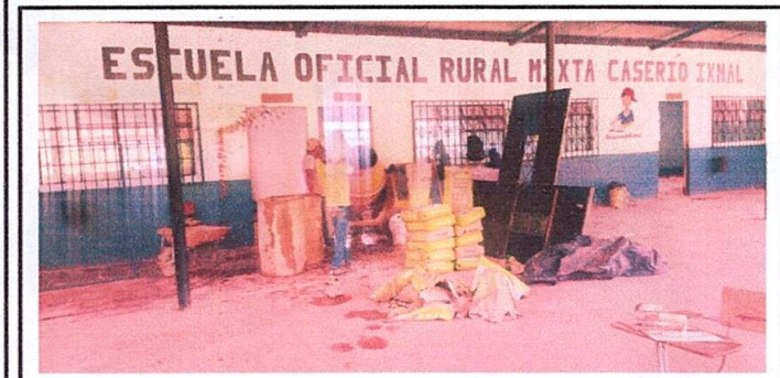
Foto 3: MANTENIMIENTO A ESTRUCTURA DE PUERTAS
