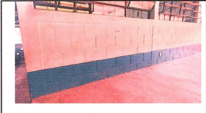
Foto 4 PINTURA EN MUROS EXTERIORES E INTERIORES
