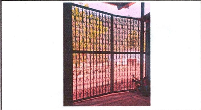
Foto 2 MANTENIMIENTO A PORTÓN
