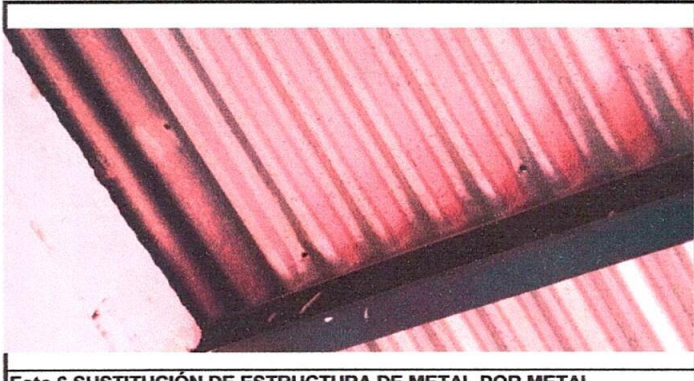
Foto 6 SUSTITUCIÓN DE ESTRUCTURA DE METAL POR METAL
