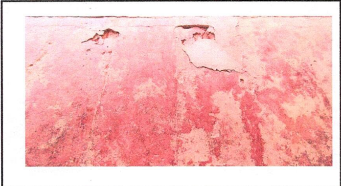
Foto 1 REPARACIÓN DE PISO DE TORTA DE CONCRETO
