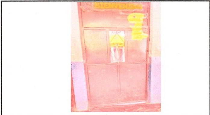
Foto 3 MANTENIMIENTO A ESTRUCTURA DE PUERTAS
