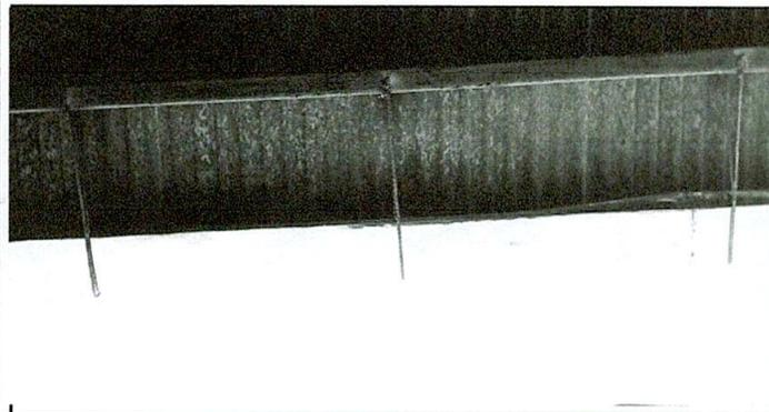
Foto 5: Sustitución de soportes de canal
