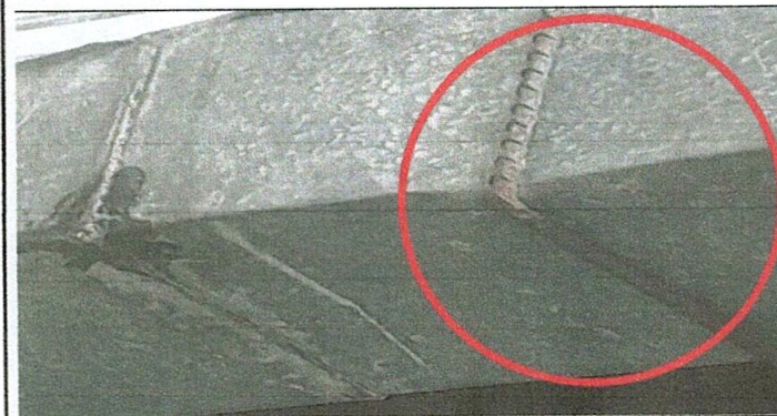
5. Sustitución de soporte o pescante de metal por canal
