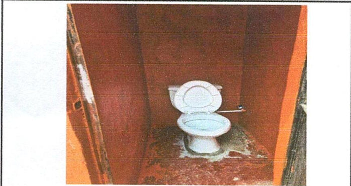
Foto 3: Sustitución de inodoro
