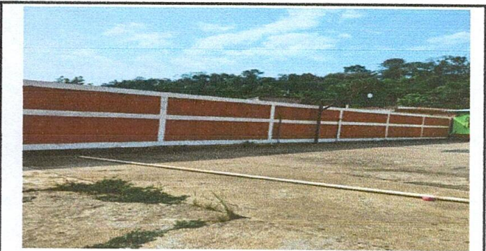
Foto 5: Pintura en muros exteriores
