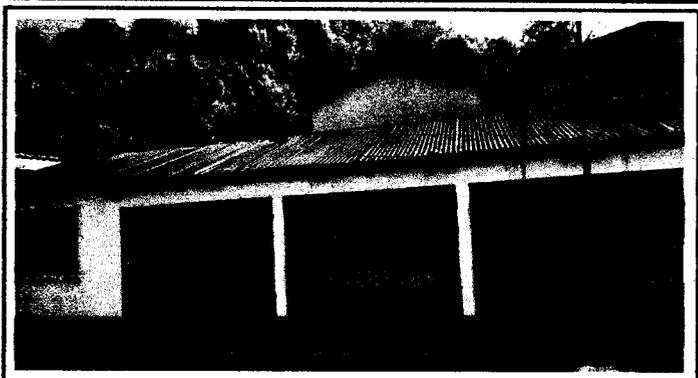
Foto 2: Sustitución de lámina, por lámina troquelada aluzinc calibre 26 12"
