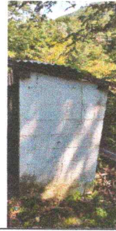
Foto 14: Sustitución de techo de baños de madera por metal
