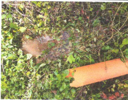
Foto 5: Sustitución de tubería PVC línea principal aguas negras más accesorios
