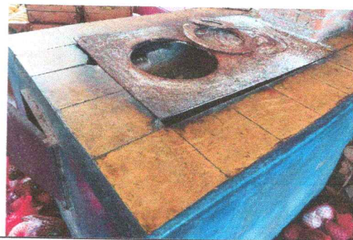
Foto 2: Sustitución de plancha de metal de 3 hornillas
