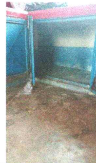
Foto 18: Sustitución de puerta de metal de gabinetes de cocina
