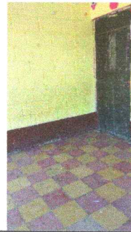
Foto 16: Fabricación e instalación de puertas de metal en aulas
