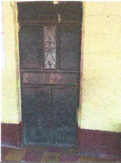
Foto 15: Fabricación e instalación de puertas de metal en aulas
