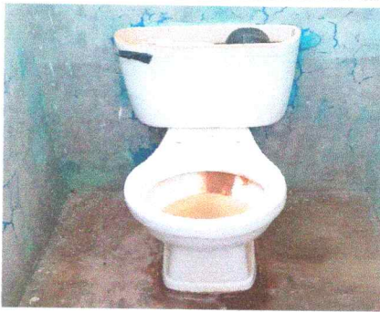
Foto 3: Sustitución de inodoro
