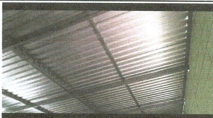
Foto 2: Sustitución de láminas.
