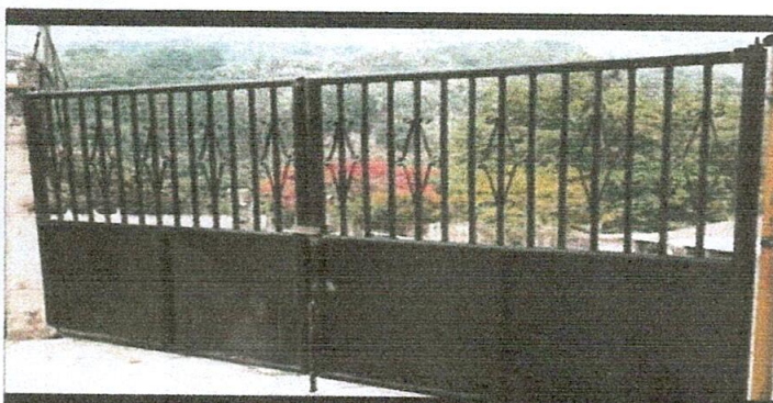
Foto 5: Sustitución de portón
