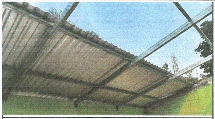
Foto 2: Sustitución de láminas
