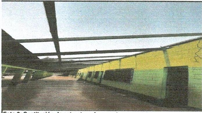
Foto 3: Sustitución de estructura de soporte.
