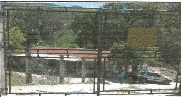
Foto 5: SUSTITUCIÓN DE PORTÓN
