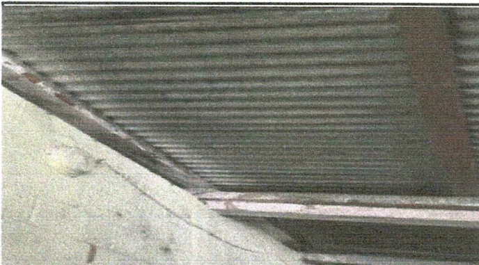
Foto 3: SUSTITUCIÓN DE ESTRUCTURA DE SOPORTE
