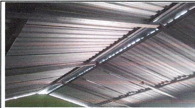
Sustitución de elementos de fijación
