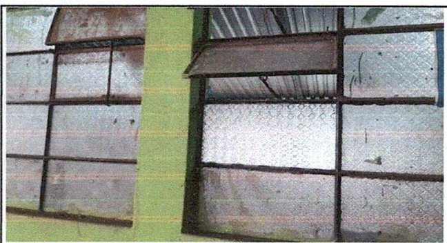
Sustitución de vidrios
