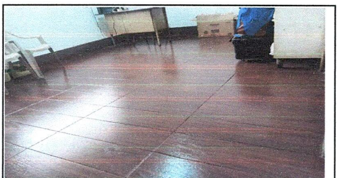
Sustitución de piso de torta de concreto por cerámico
