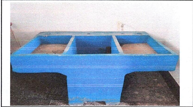
Sustitución de pila de cemento de dos lavaderos
