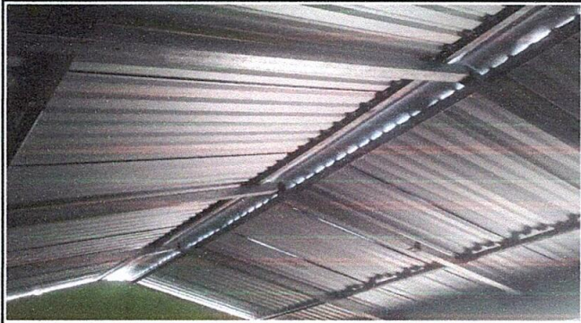
Sustitución de lámina por lámina troquelada aluzinc calibre 26 de 12 pies
