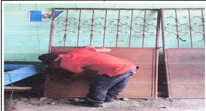
Mantenimiento a portón de metal
