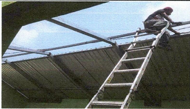
Sustitución de lámina por lámina troquelada aluzinc calibre 26 de 12 pies
