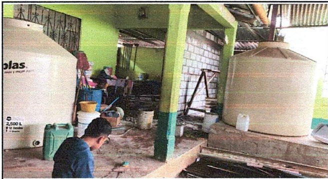
Sustitución de depósito de agua 2500 lts
