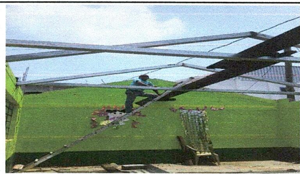
Sustitución de estructura de soporte de madera por metal
