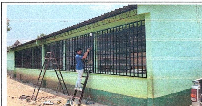
Fabricación e instalación de balcones de hierro en ventana
