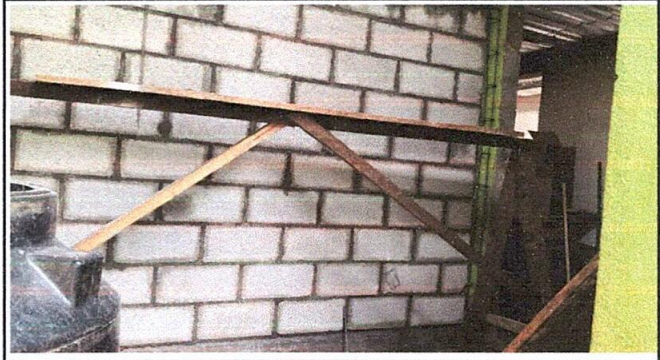
Mejoramiento de pared división de cocina
