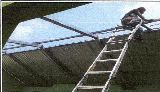
Sustitución de elementos de fijación
