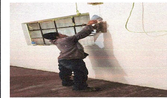
Repello en muro
