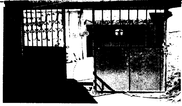
Mantenimiento de portón de metal
