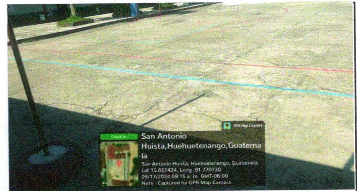
Foto 4: Reparación de piso de torta de concreto
