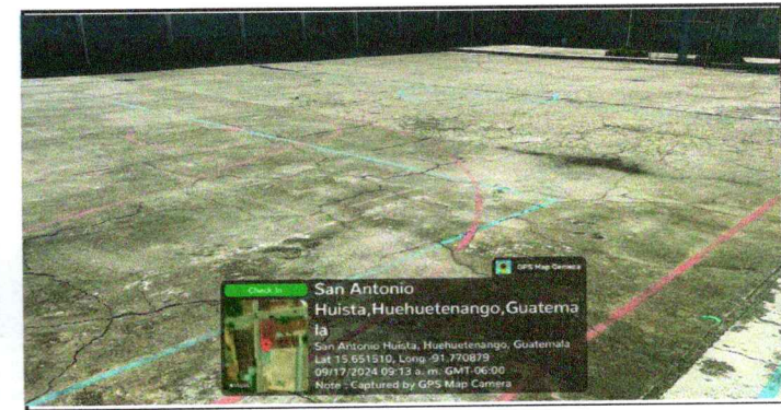
Foto 6: Reparación de piso de torta de concreto
