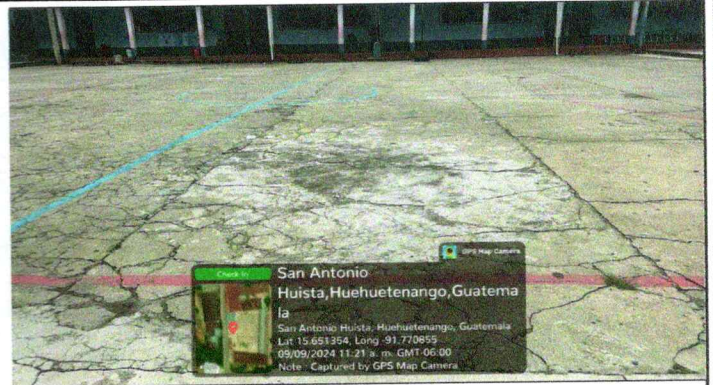
Foto 2: Reparación de piso de torta de concreto
