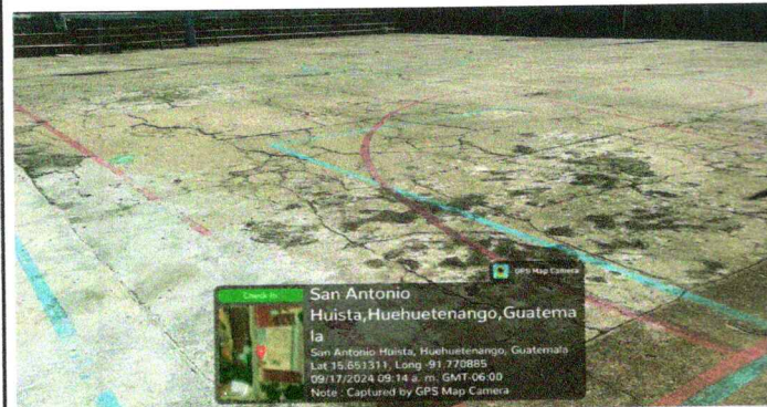
Foto 5: Reparación de piso de torta de concreto
