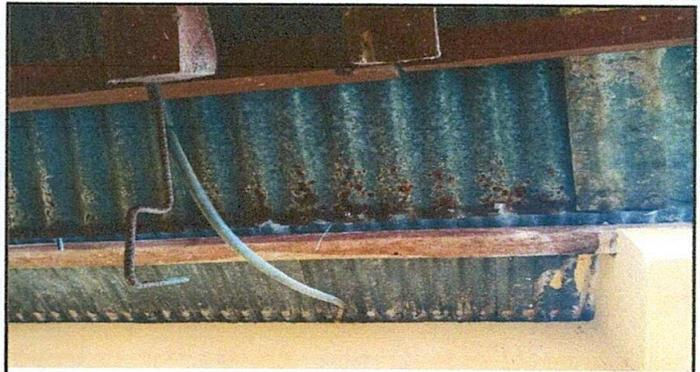
Foto 2: Estado de las láminas y estructuras de soporte en las goteras
