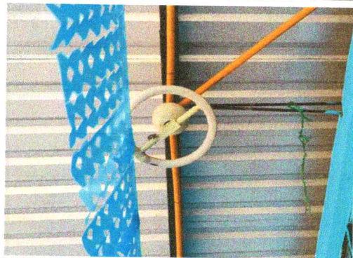
Foto 3: Reparación de lámparas
