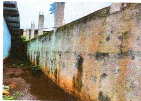
Foto 4: Pintura en muros exteriores e interiores
