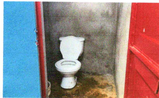
Foto 6: Sustitución de inodoro
