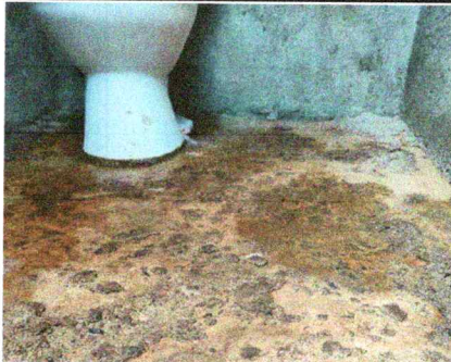
Foto 5: Sustitución de inodoro
