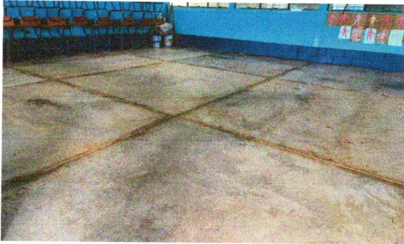
Foto 1: Sustitución de Piso de concreto por piso de granito
