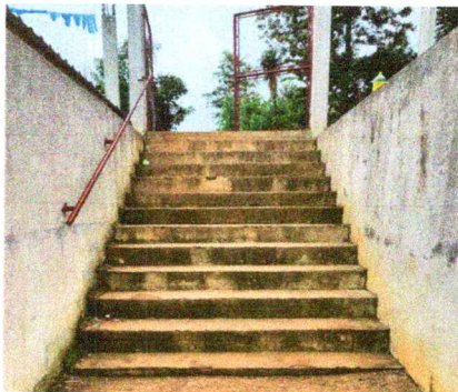
Foto 3: Pintura en muros exteriores e interiores
