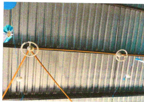
Foto 4: Reparación de lámparas
