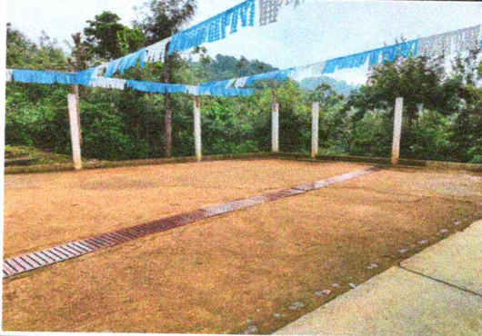
Foto 1: Reparación de muro perimetral de block con tubo hg y malla galvanizada, soleras intermedias y columnas.
