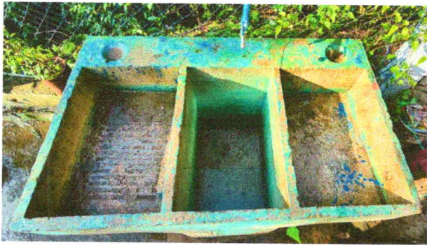
Foto 3: Sustitución de pila de cemento de dos lavaderos, por pila plástica de dos Lavaderos
