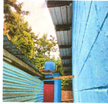
Foto 2: sustitución de deposito de agua 1700
