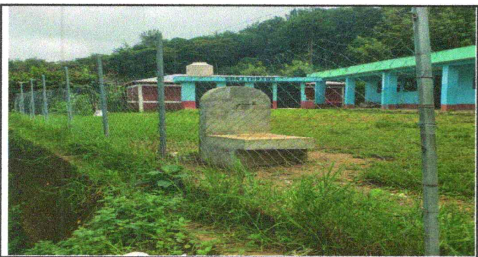
Foto 5: CAMBIAR POR MURO PERIMETRAL
