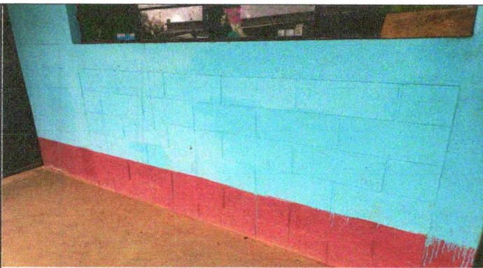
Foto 15: PINTAR PARED EXTERIOR
