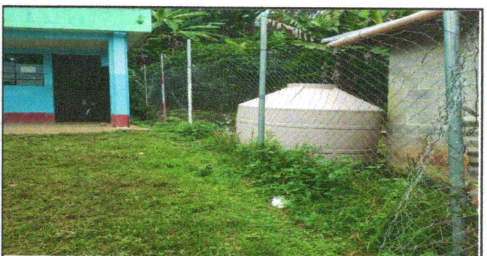
Foto 6: CAMBIAR POR MURO PERIMETRAL
