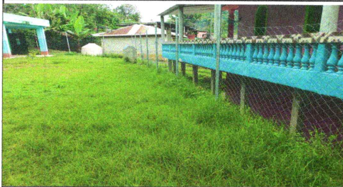
Foto 7: CAMBIAR POR MURO PERIMETRAL
