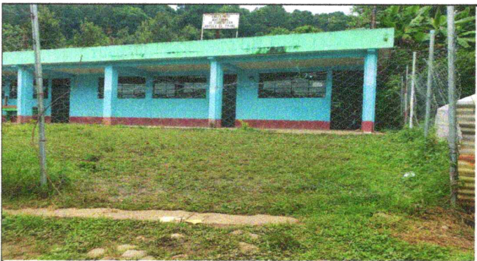
Foto 9: CAMBIAR POR PORTON DE METAL
