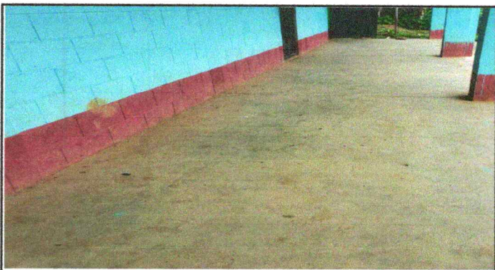
Foto 3: COLOCAR PISO DE GRANITO
