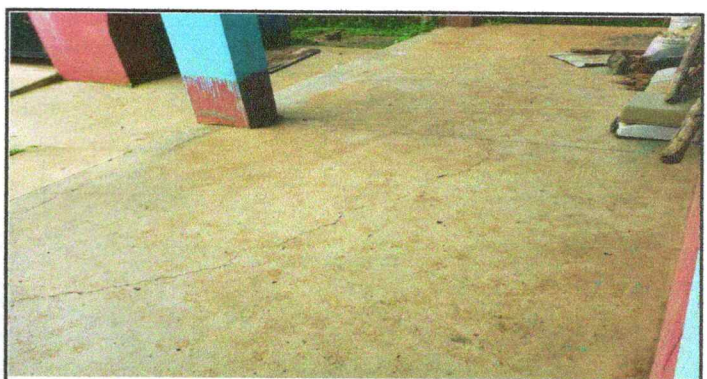
Foto 4: COLOCAR PISO DE GRANITO
