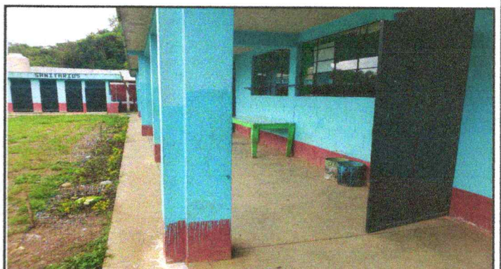
Foto 16: PINTAR PARED EXTERIOR
