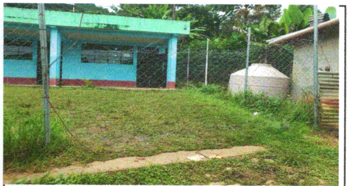
Foto 10: CAMBIAR POR PORTON DE METAL
