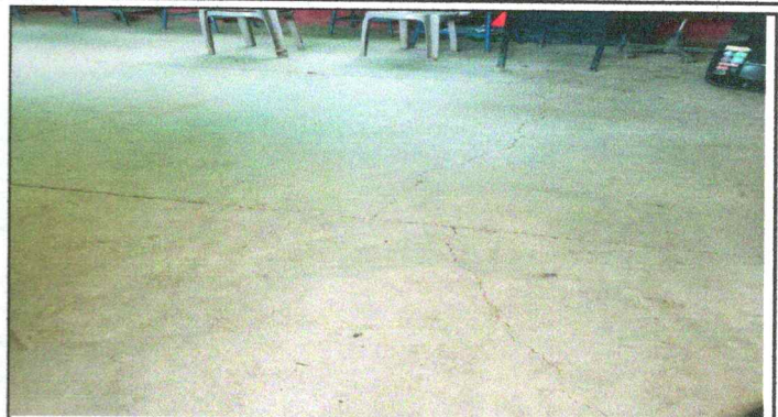
Foto 2: COLOCAR PISO DE GRANITO
