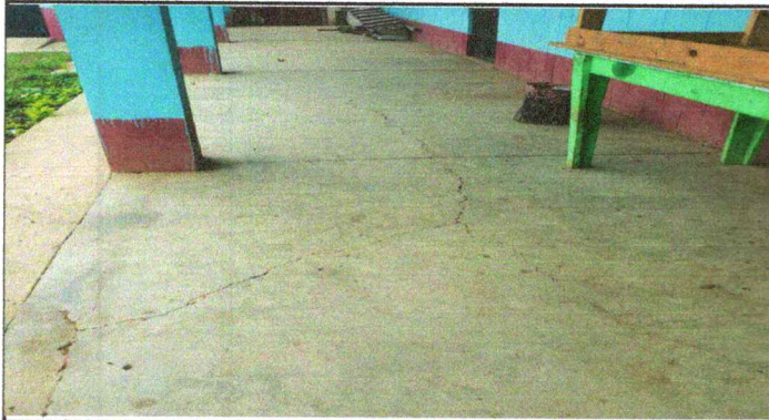
Foto 1: COLOCAR PISO DE GRANITO
