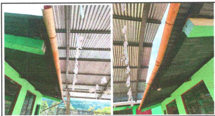
Foto 5: Sustitución de canal de pvc
