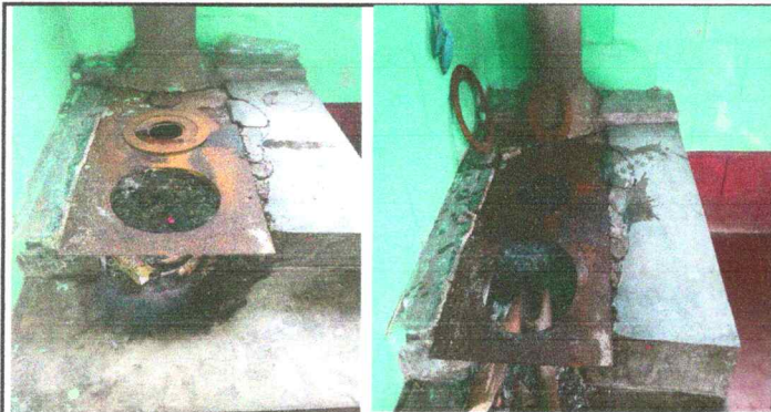
Foto 7: Sustitución de estufa rural (completa) incluye chimenea y plancha de metal
