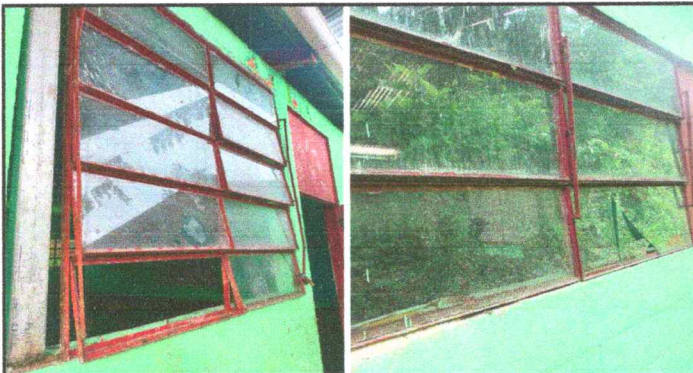
Foto 3: Sustitución de estructura de metal de ventana
