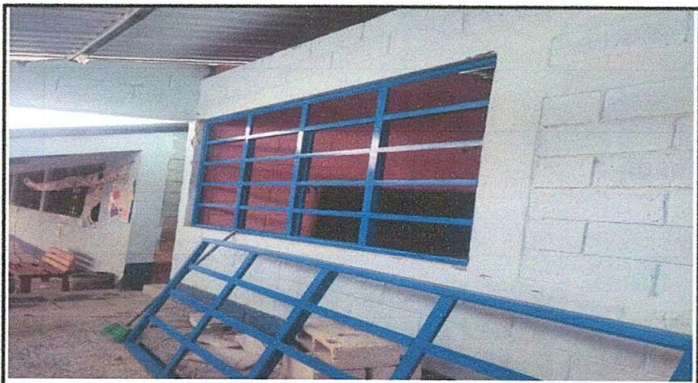
Sustitución de estructura de ventanas y vidrios
