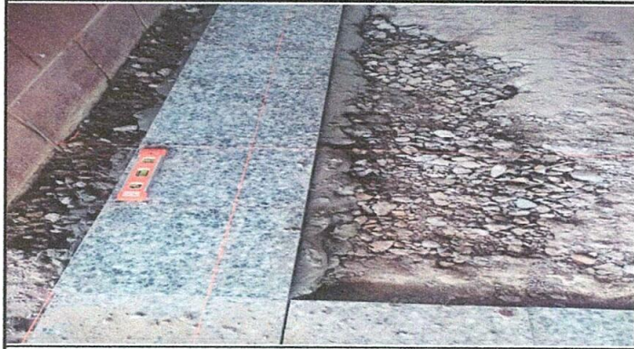
Sustitución de piso de torta de cemento por piso granito.
