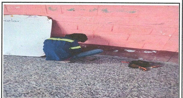
Sustitución de tomacorriente y sistema de cableado electrico
