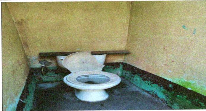
Foto 7: Sustitución de inodoro
