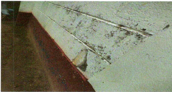
Foto 15: Pintura en muros exteriores e interiores
