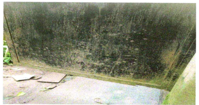
Foto 22: Sustitución de puerta en servicios sanitarios
