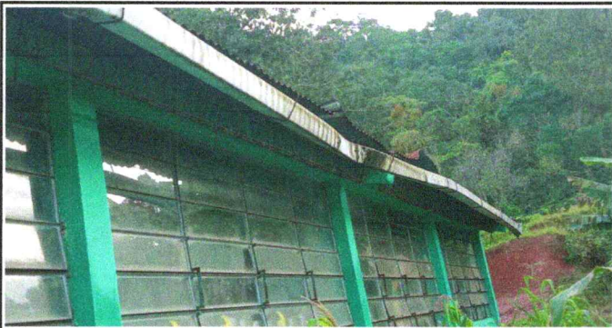
Foto 17: Sustitución de bajada de agua pluvial, tubo PVC 3"
