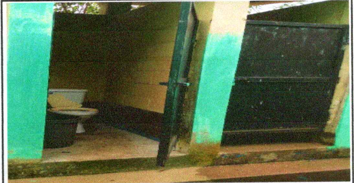
Foto 8. Sustitución de inodoro
