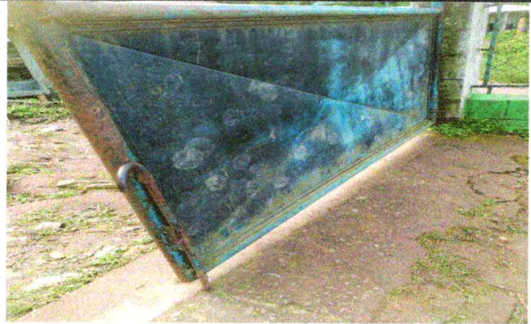
Foto 14: Mantenimiento a portones de metal
