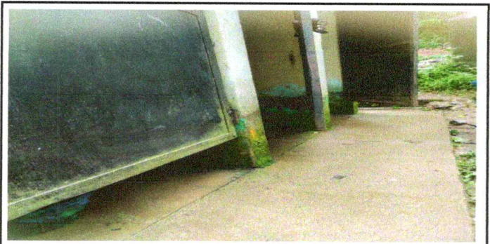
Foto 21: Sustitución de puerta en servicios sanitarios
