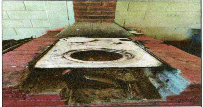
Foto 2: Sustitución de estufa rural (Completa) incluye chimenea y planca de metal
