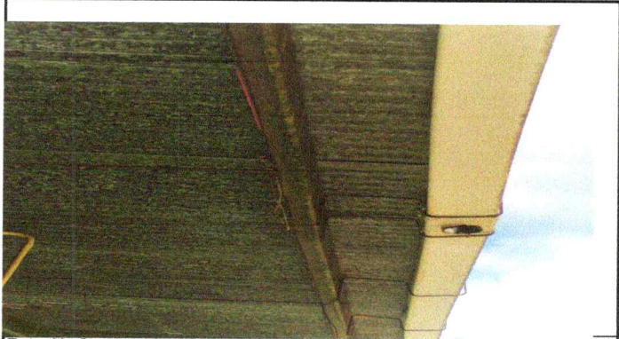
Foto 19: Sustitución de canal de pvc
