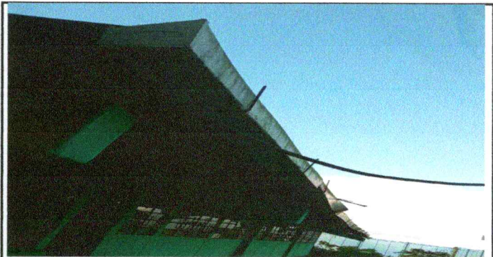
Foto 18: Sustitución de bajada de agua pluvial, tubo PVC 3"
