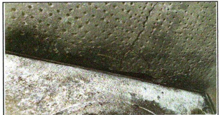
Foto 4: Instalación de azulejo en estufa rural
