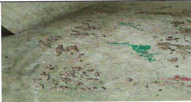
Foto 9: Sustitución de piso de torta de concreto por piso granito
