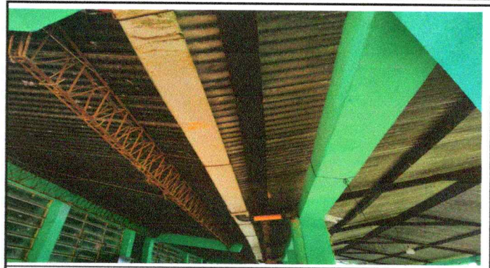
Foto 20: Sustitución de canal de pvc
