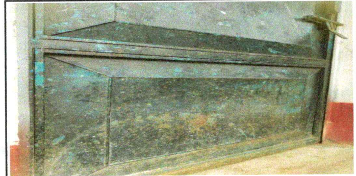
Foto 12: Mantenimiento a estructura (lijado, cambio de tubo, cepillado, sujeciones, aplicación de pintura)
