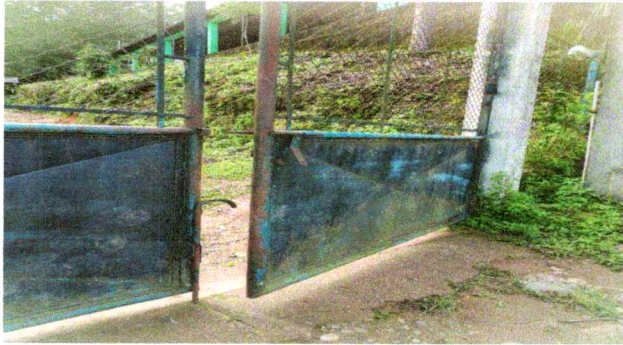
Foto 13: Mantenimiento a portones de metal
