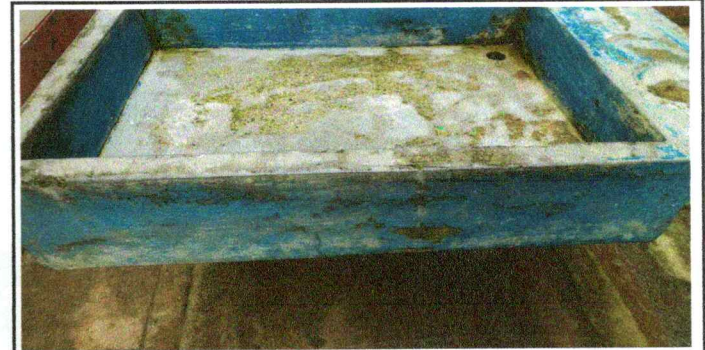
Foto 6: Sustitución de pila de cemento de 2 lavadores
