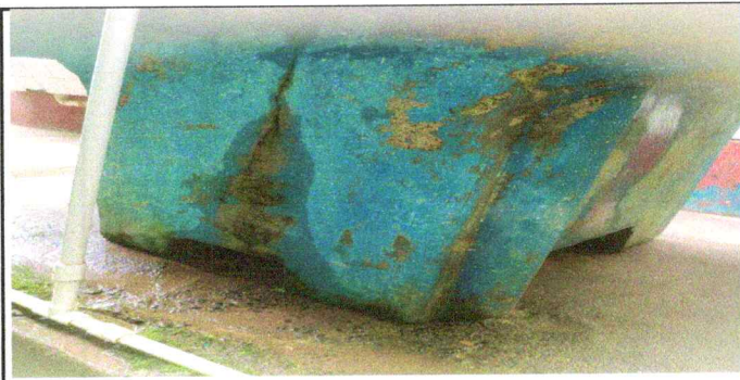
Foto 5: Sustitución de pila de cemento de 2 lavadores
