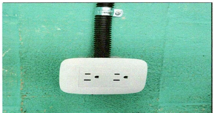
Foto 6: SUSTITUCIÓN DE TOMACORRIENTES ✓
