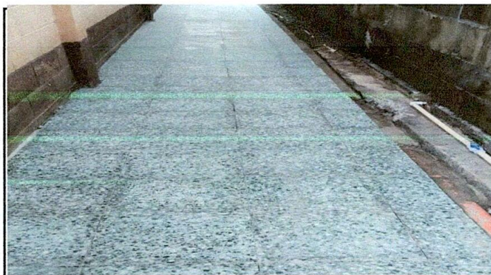
Foto 3: SUSTITUCIÓN DE PISO DE TORTA DE CEMENTO POR PISO DE GRANITO ✓
