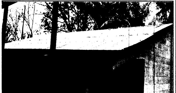
Foto 2: Sustrucción de techo de aula
