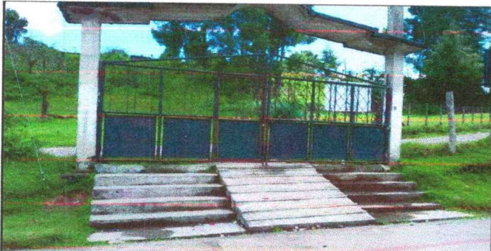
Foto 3: Mantenimiento a portón de entrada del centro educativo
