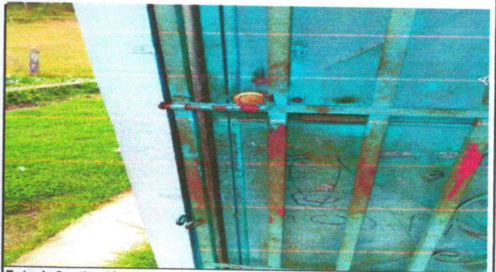
Foto 4: Sustitución de puertas en aulas de 2.2m*95cm
