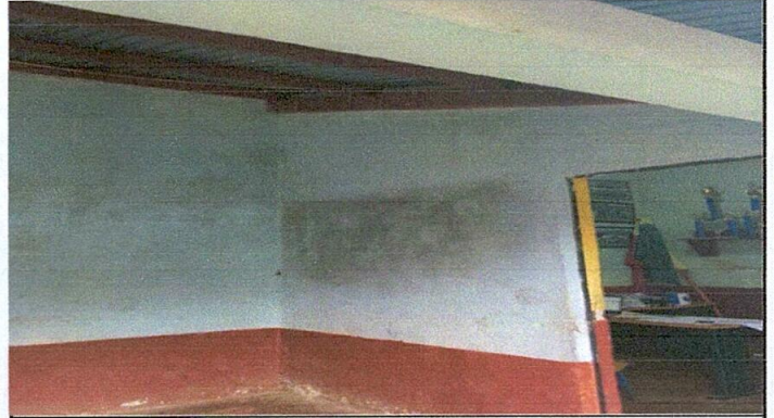
Foto 2: Sustitución de madera por metal
