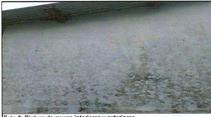
Foto 5: Pintura de muros interiores y exteriores
