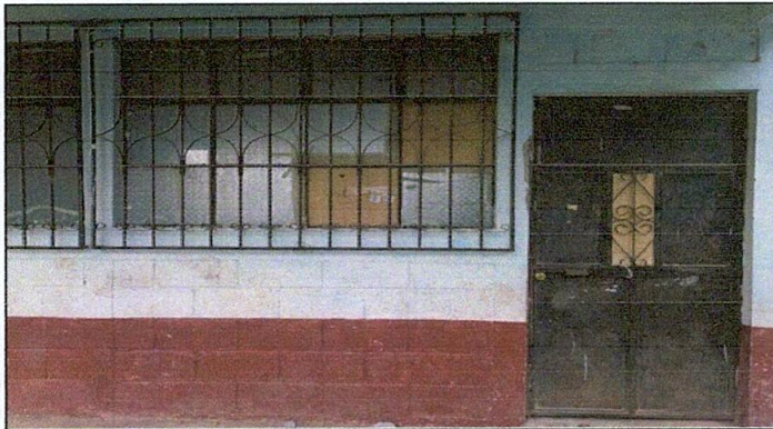
Foto 3: Sustitución de vidrios
