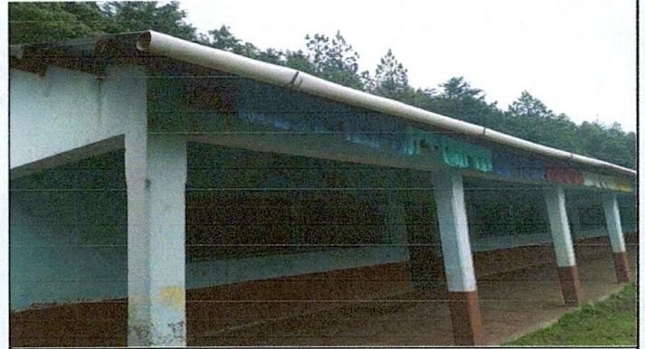
Foto 4: Sustitución Canales y bajadas de agua pluvial
