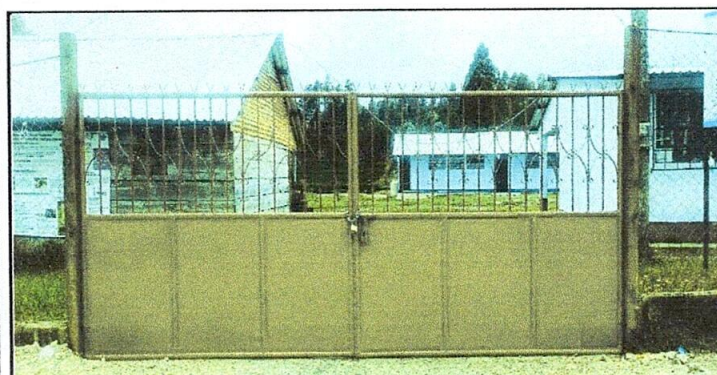
Foto 3: Mantenimiento a portones de metal.
