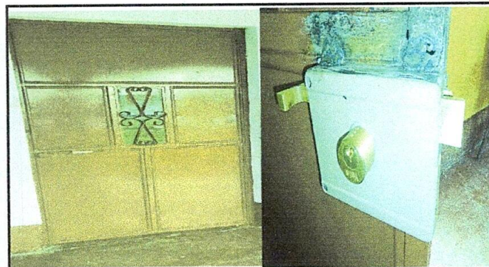
Foto 4: Mantenimiento a estructuras de puertas en aulas.
