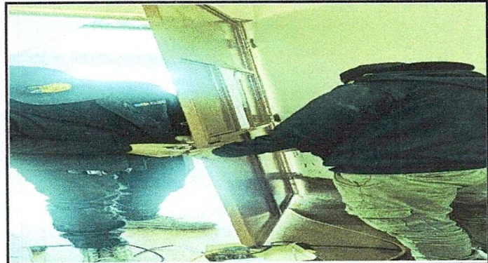
Foto 4: Mantenimiento a estructuras de puertas en aulas.
