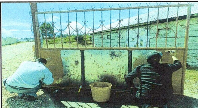
Foto 3: Mantenimiento a portones de metal.
