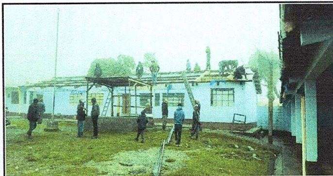
Foto 5: Cambio de techo de la cocina
