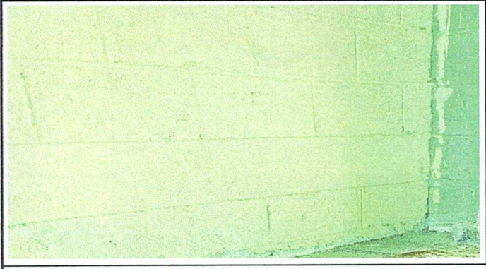
Foto 2: Reparación de repello y cernido de paredes.
