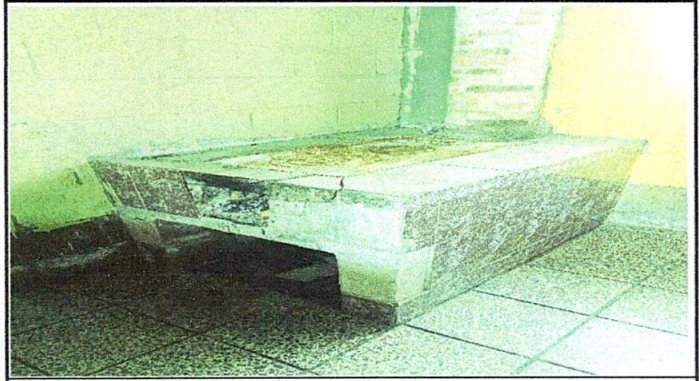
Foto 1: Sustrucción de plancha de metal.
