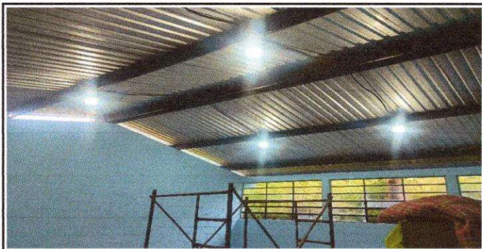
Foto 5: Sustitución de pintura de estructura metálica.
