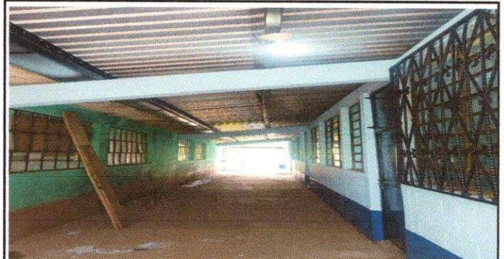
Foto 2: Sustitución de red eléctrica
