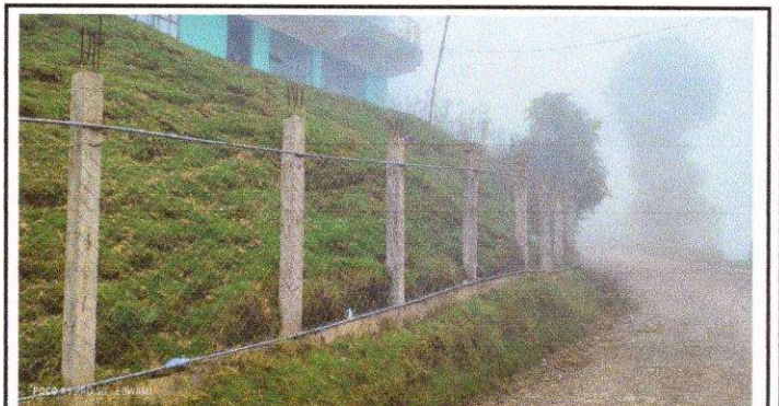
Foto 4: Sustitución de malla
