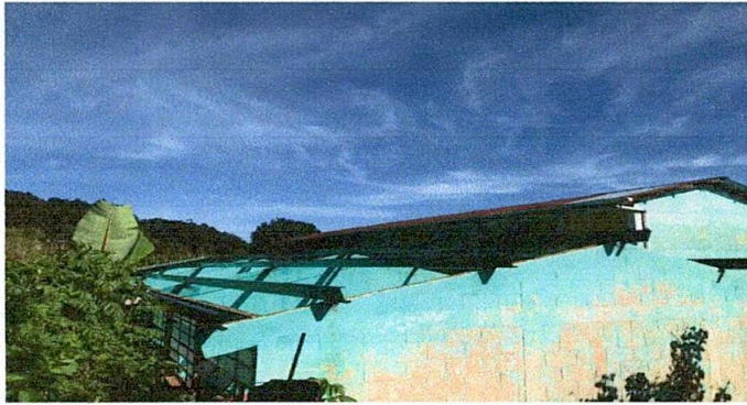
Foto1: Sustitución de lamina
