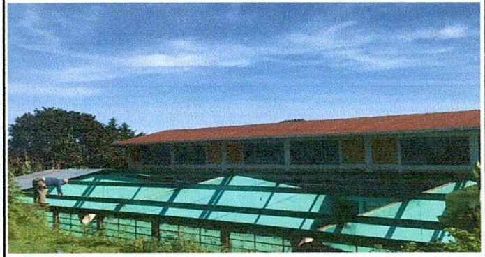
Foto 2: Sustitución de lamina
