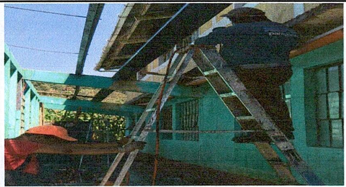
Foto 3: Sustitucion de pintura de estructura metalica
