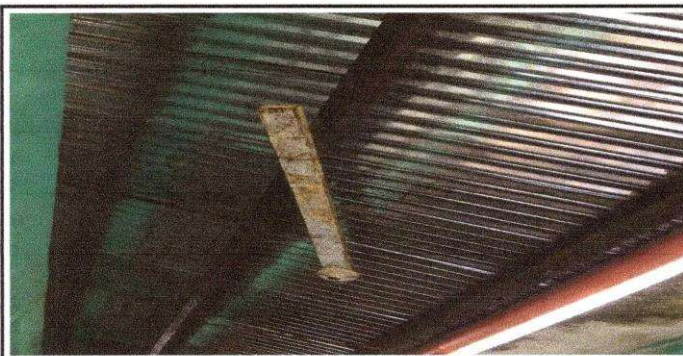
Foto 5: Sustrución de pintura de estructura metalica
