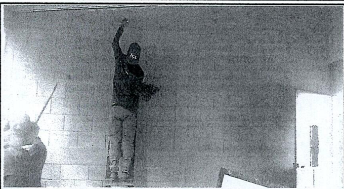
Foto 14: Sustitución de Pintura del interior de las aulas
