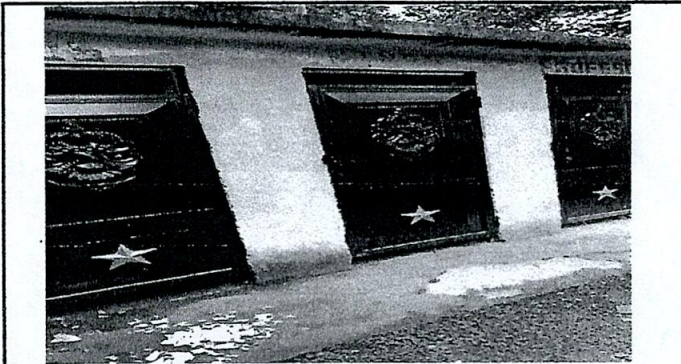
Foto 6: Sustitución de Puertas de Baño
