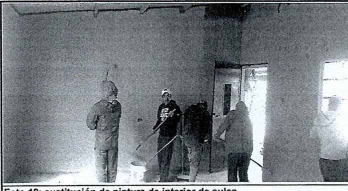
Foto 18: sustitución de pintura de interior de aulas
