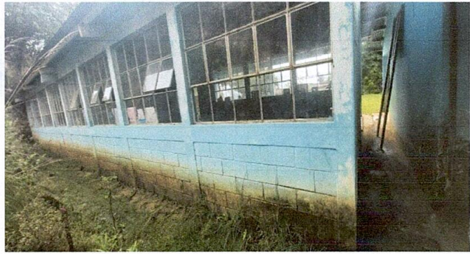
Foto 13: Sustitución de Pintura exterior de las aulas
