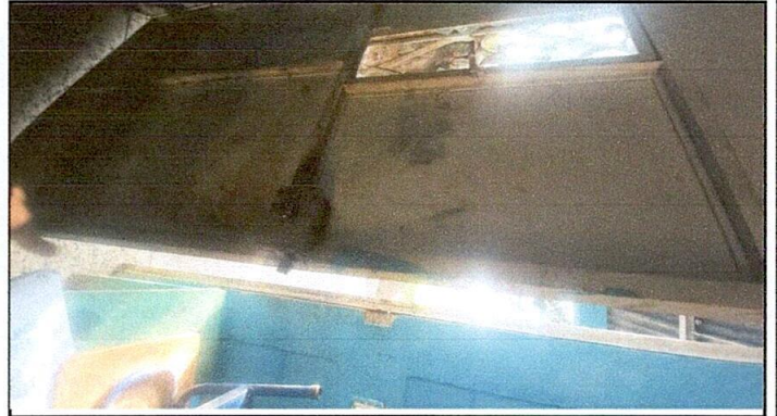
Foto 8: Cambio de chapa de puerta de aula
