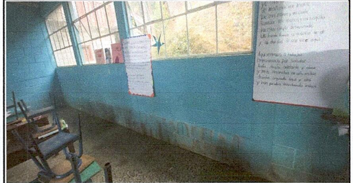
Foto 14: Sustitución de Pintura del interior de las aulas
