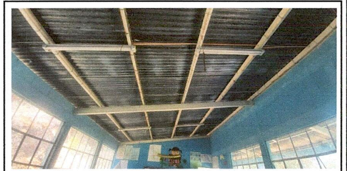
Foto 12: sustrucción de cableado y reparación de tubo flexible
