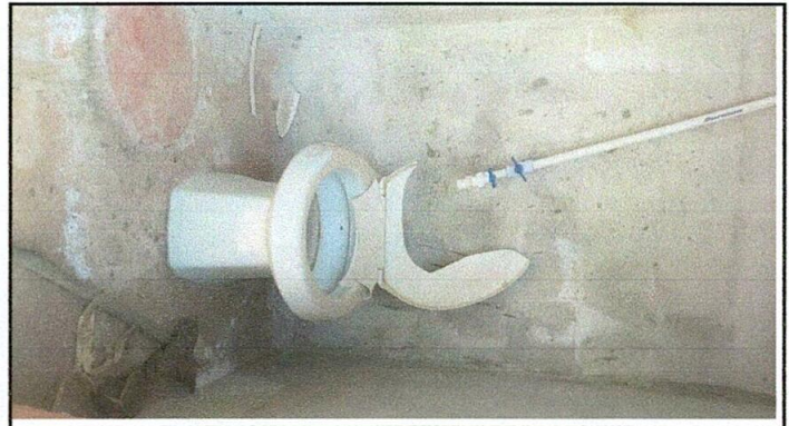
Foto 2: Sustitución de inodoros
