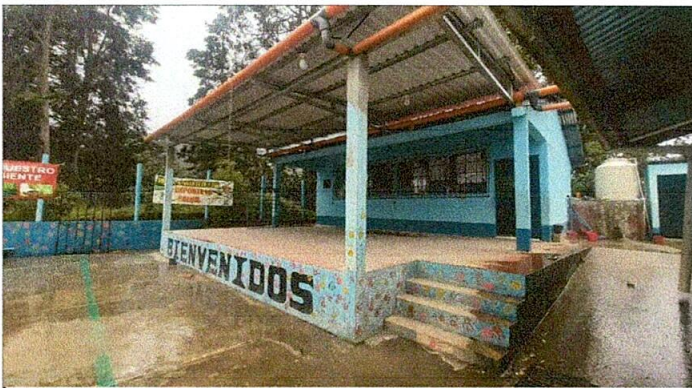
Foto 3: Cambio de techo de escenario terminada.
