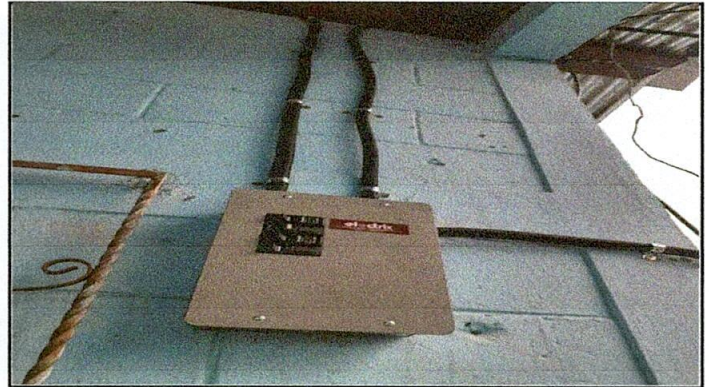
Foto 2: cambio de interruptores y conexiones eléctricasterminadas.
