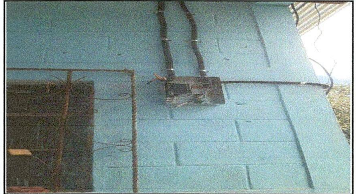
Foto 2: Colocación de cajas interruptoras e instalaciones eléctricas
