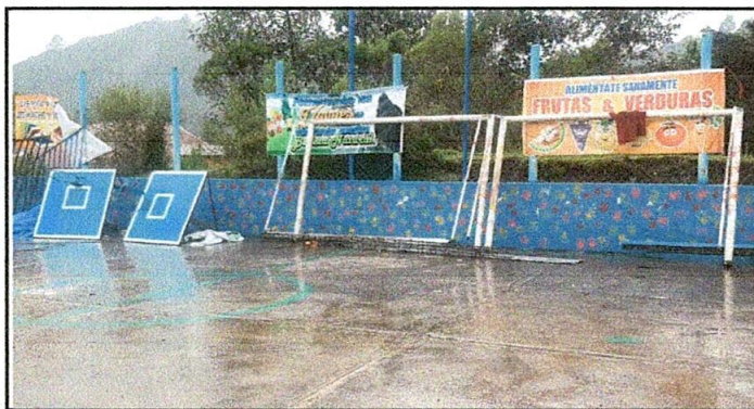
Foto 5: Porterías y aros cortados para repararlas.
