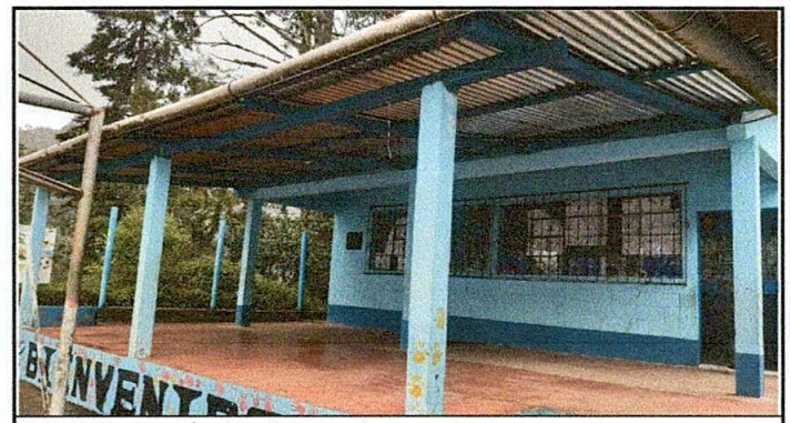
Foto 6: Sustrucción de columnas de concreto por concreto.
