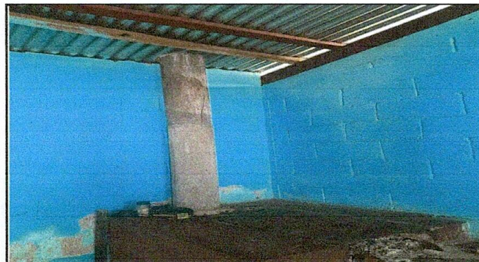
Foto 3: Construcción de 2 estufas artesanales con chimenea de ladrillo.
