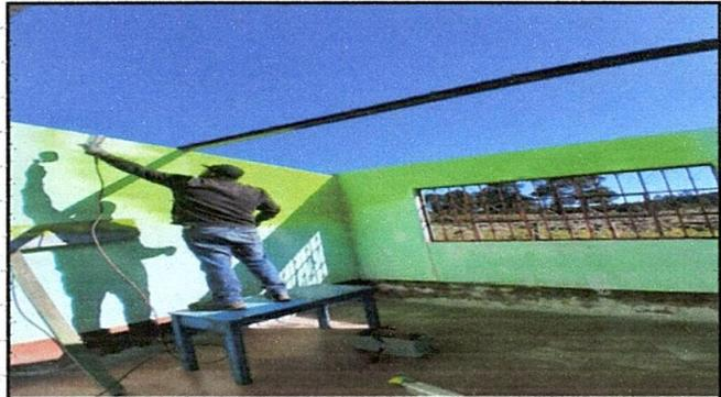
Foto 4: Pintura en muros exteriores e interiores
