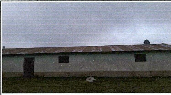
Foto 4: Pintura en muros exteriores e interiores
