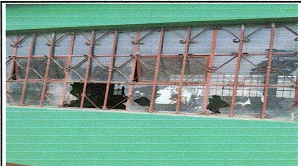
Foto 2: Sustitución de vidrios
