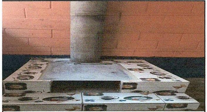
Foto 8: Remodelación de estufa artesanal y cambio de planchas con chimenea. N0. 1
