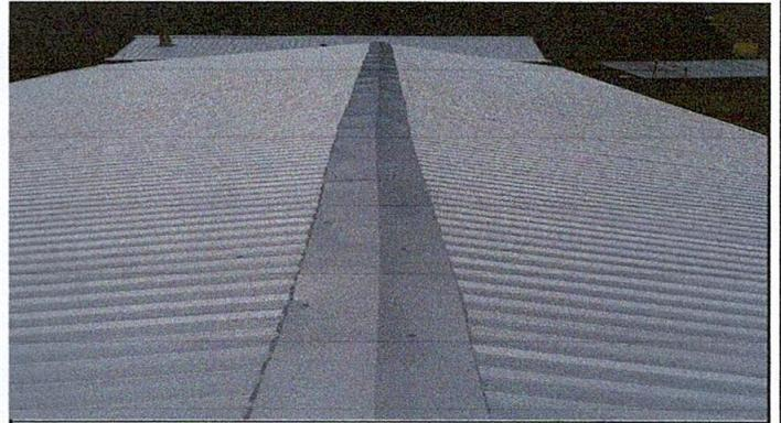
Foto 2: Sustitucion de lamina de aulas de 10. 3o., 4o. y 6o. por lámina troquelada.
