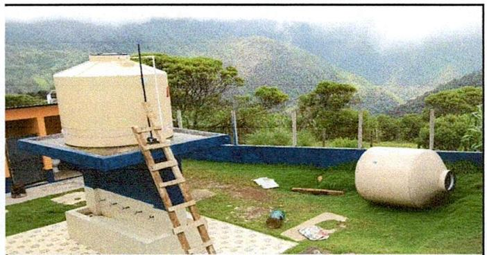
Foto 6: Sustitución de depósito de agua de 2,500LT
