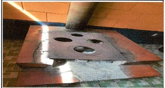
Foto 8: Remodelación de estufa artesanal y cambio de planchas con chimenea. NO. 1
